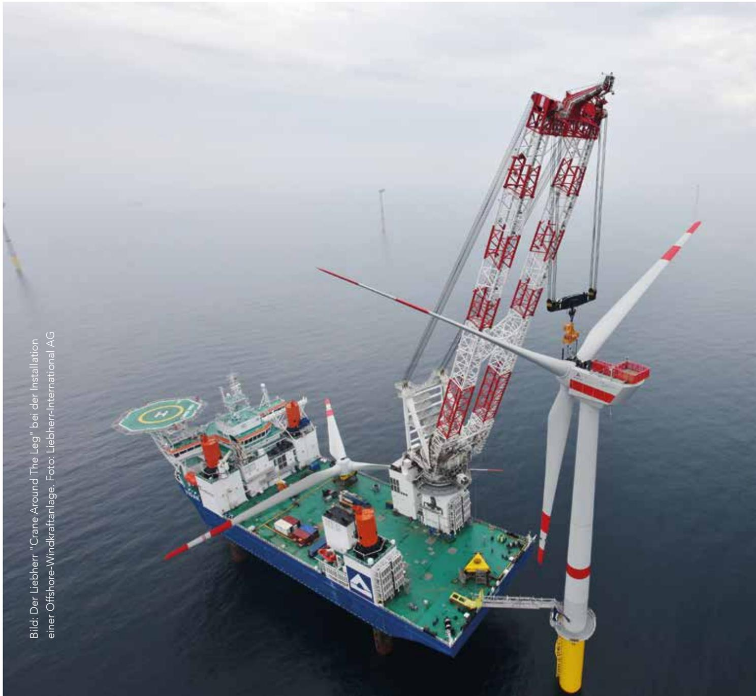
Bild: Der Liebherr "Crane Around The Leg" bei der Installation einer Offshore-Windkraftanlage. Foto: Liebherr-International AG
